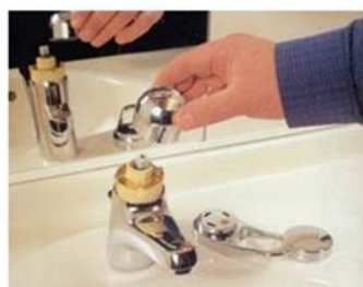
6 Desserrer les deux vis de maintien de la cartouche
