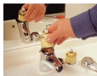
8 Reposer la nouvelle cartouche en l'engageant correctement. Serrer à fond les deux vis et procéder pour le montage dans le sens inverse du démontage.
