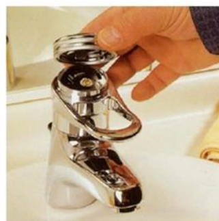
2 Retirer la garniture de recouvrement (cache) par simple traction dans l'axe de la tête de robinet.
