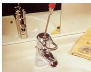
3 Desserrer la vis de maintien de la platine supérieure.
